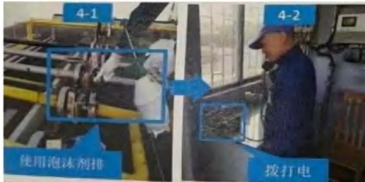
5.设备课人员维修好后，值班员再次使用“泡沫剂”对泄漏位置喷洒确认已无气泡冒出，表明气体泄漏维修成功。
