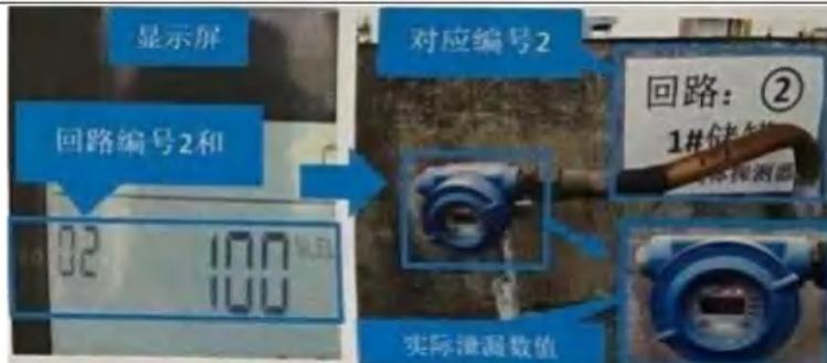
4.值班员拿取泡沫剂，在该“点型气体探测器”附近的管道阀门和接头采用“喷泡沫剂”的方式排查发生泄漏的位置（有气泡冒出表示泄漏）。确定好发生泄漏的位置后，迅速打电话联络设备课人员维修。
